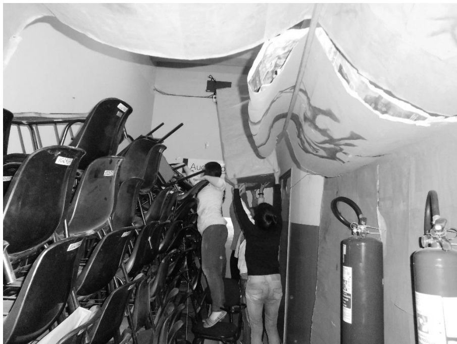
Figura 14: Montagem da parede e do teto. Arquivo pessoal.
